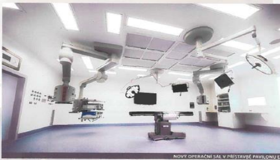
NOVÝ OPERAČNÍ SÁL V PŘÍSTAVBĚ PAVILONU E
